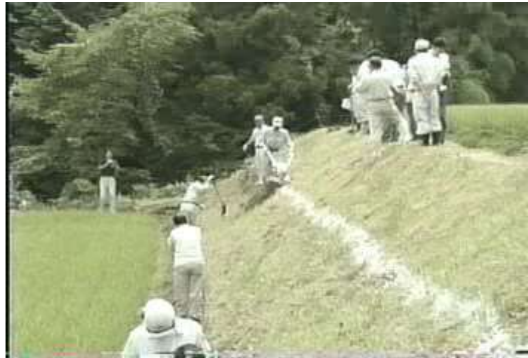
多段テラスの設置
