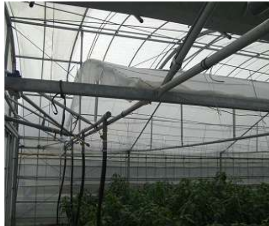
2重ネットハウス内部 (内側ネットを掛けた状態)
