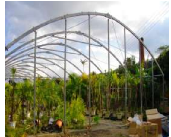
補修完了 新築同様の概観
