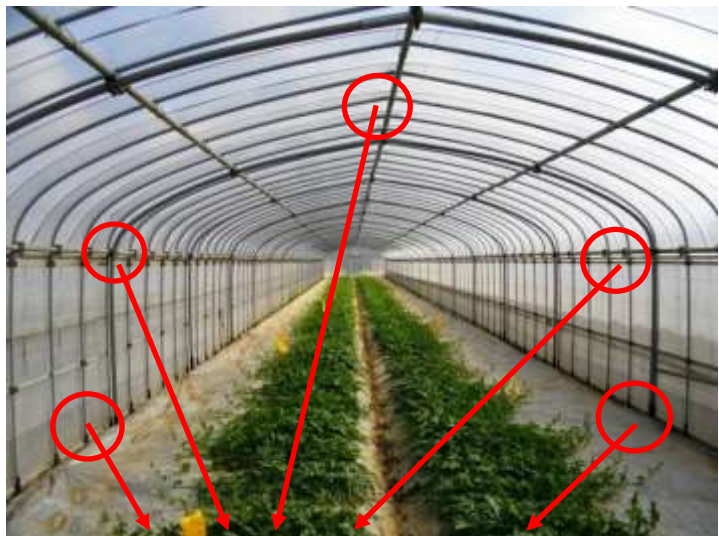
桁行 \phi 42.7\text{mm} 直管パイプ5箇所
