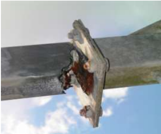
補修前の谷柱
